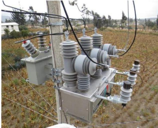
*Fig. 14. Reconectador automático.*
