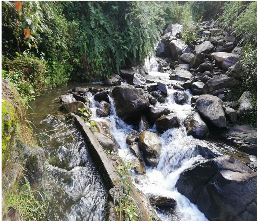
Figura 45. Captación del canal alto Monte Olivo - San Rafael.
