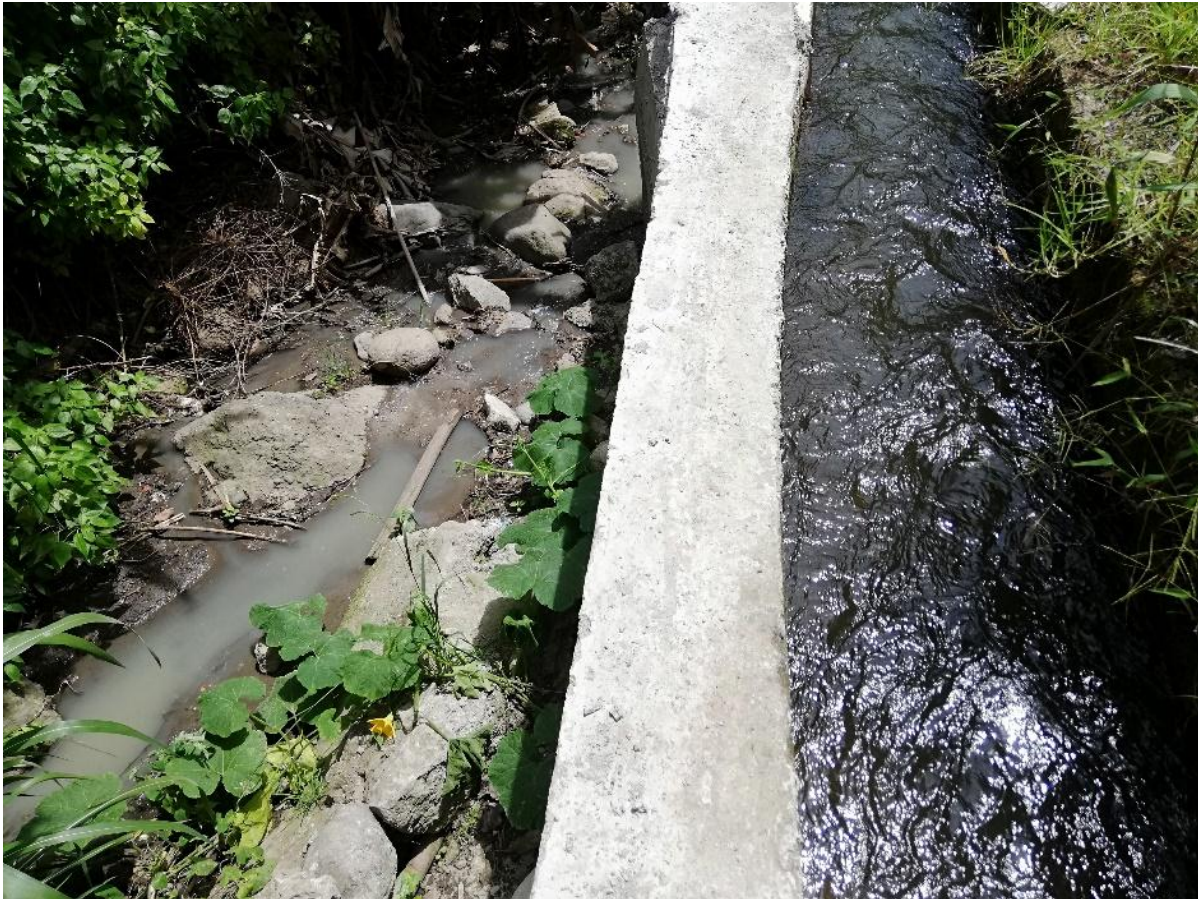
Figura 19. Disposición de aguas residuales junto al canal bajo del sistema de riego Monte Olivo – San Rafael.
