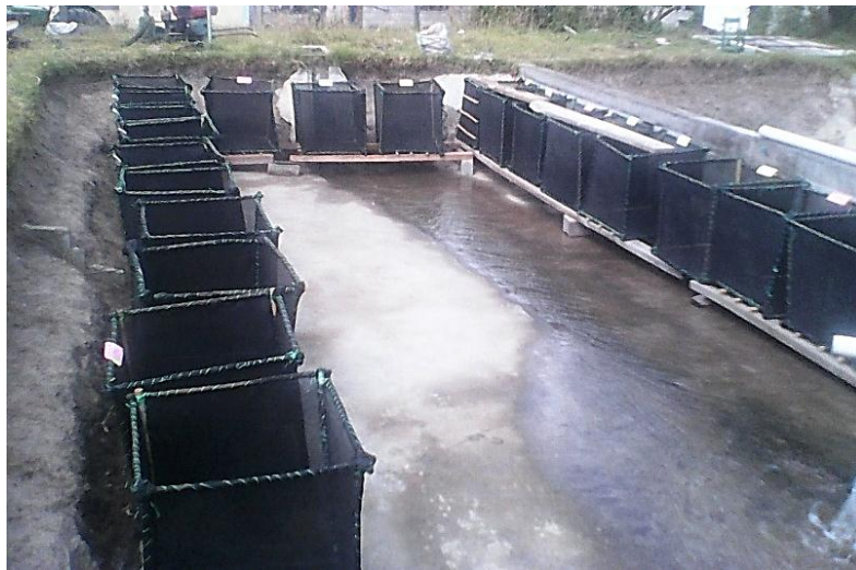
Figura 17. Construcción de las jaulas.
