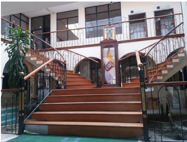
Figura 27. Graderíos y escaleras Fuente: GADM Urcuquí.
