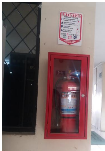
Figura 29. Limpieza en instalaciones Fuente: GADM Urcuqui.
