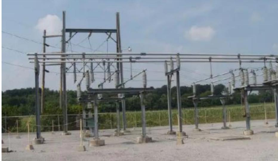
**Fig. 2** Barraje de una subestación Eléctrica
