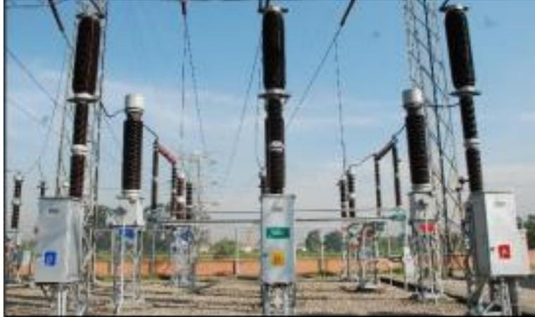
**Fig. 7** Interruptor de potencia
