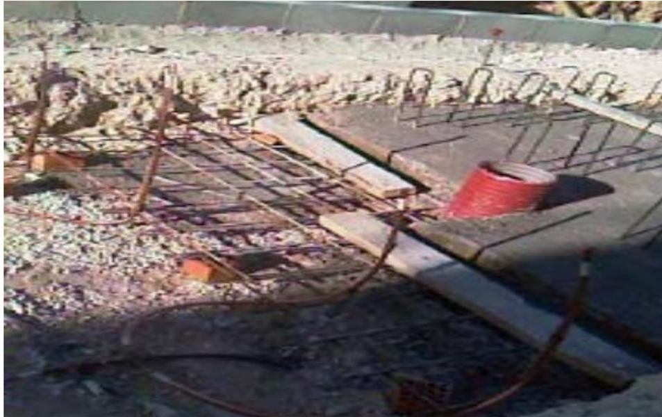
**Fig. 10** Sistema de puesta a tierra
