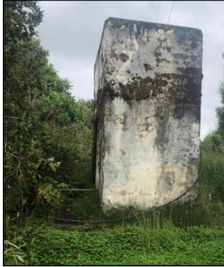
**Figura 4.19.** *Tanque de almacenamiento de agua.*
