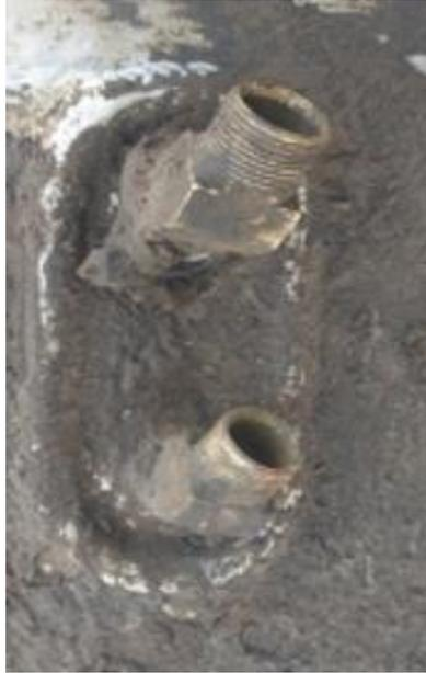
**Figura 3.55** Acoples de contenedor antes de ser arenados
