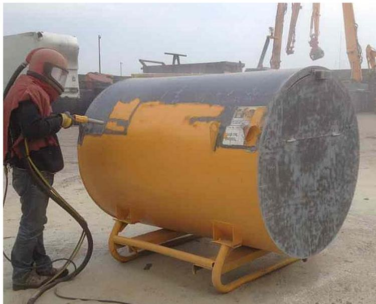
**Figura 1.2** Limpieza con máquina arenadora
