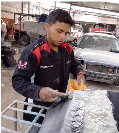
**Figura 3.43** Aplicación de la mezcla
