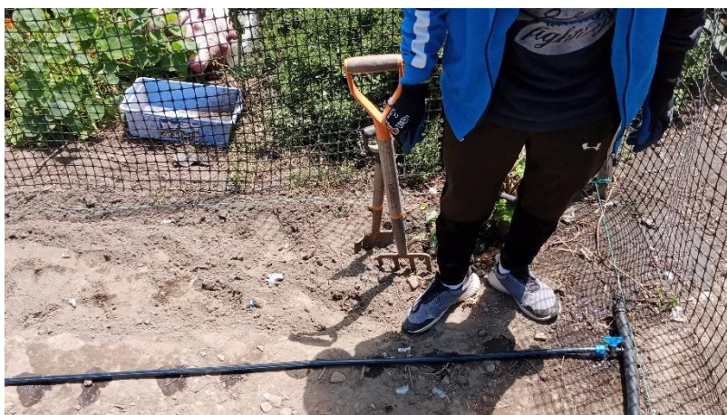
Fig. 25 Instalación de zona H
