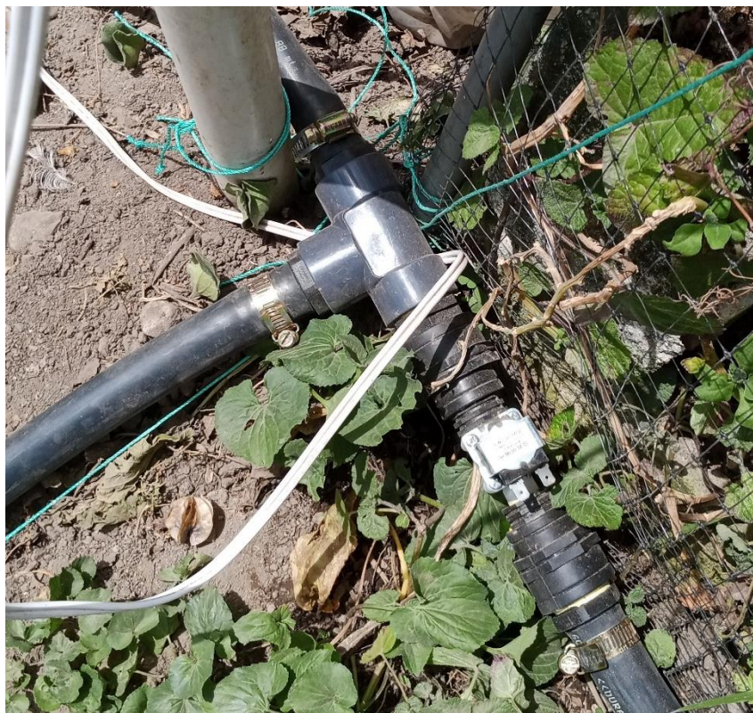
Fig. 22 Instalación de zona C y D
