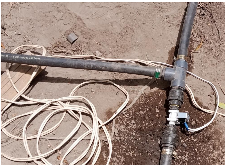
Fig. 23 Instalación de zona E y F
