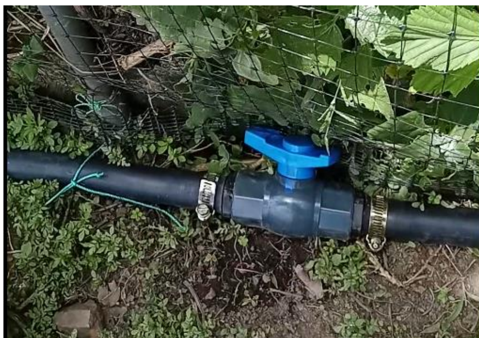
Fig. 21 Instalación de zona B
