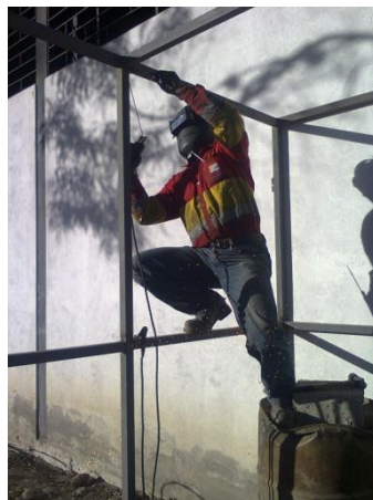
Fig. N°53 Montaje Y Soldadura De La Estructura De La Cámara De Pintura Automotriz
