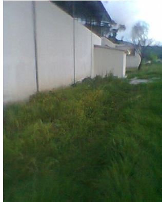
Fig. N° 44 Área De Asentamiento De La Cámara De Pintura
