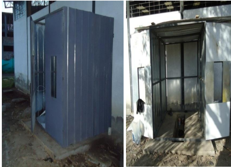
Fig. N°54 Montaje y Centrado De Planchas Galvalumen
