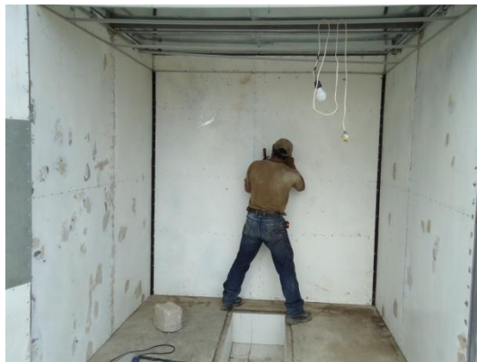
Fig. N°57 Sellado Del Aislamiento Térmico
