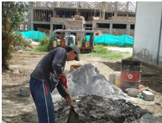
Fig. N°47 Construcción De La Plancha De Concreto (paso 2)
