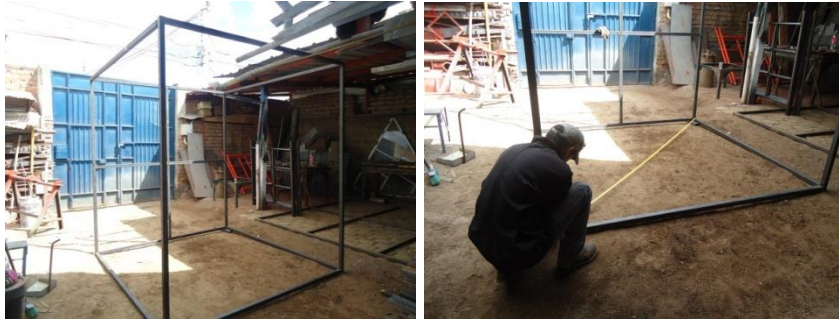
Fig. N°51 Primer Armado De Estructura De La Cabina
