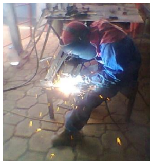
Fig. N°52 Soldadura Final De Los Accesorios Que Conformaran La Parte Primera De La Cabina De Pintura
