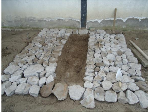
Fig. N°46 Construcción De La Plancha De Concreto (paso 1)
