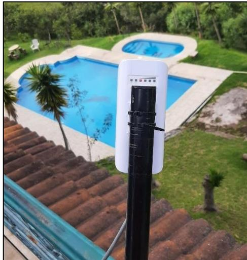
*Nota: En la figura se puede visualizar el posicionamiento de la antena Ubiquiti Loco M2, utilizada para la conexión Wifi.*
