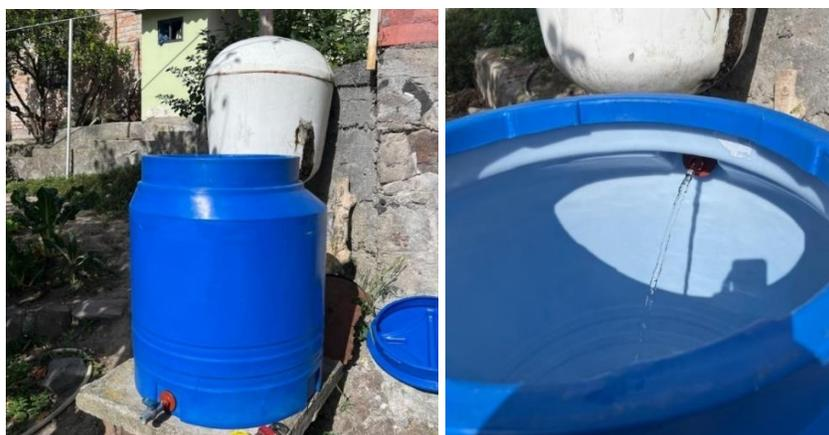
**Fig. 33** Tanque con filtro y de reservorio de 250L
