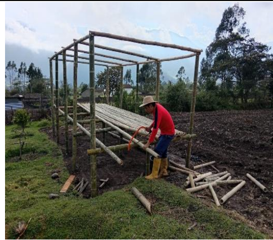
Construcción de un invernadero
