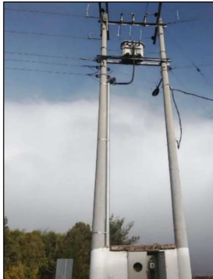
Fig. 35 Transición de red de medio voltaje a bajo Voltaje.
