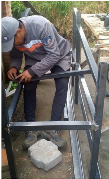
Fig. 4.24 Armado de estructura principal.
