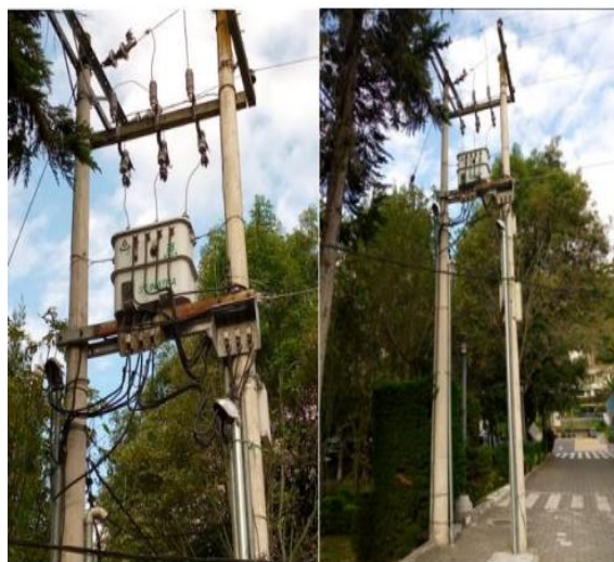
Fig. 12 Transformador de 75 kVA que suministra electricidad a los edificios de FICA y FICAYA [47].
