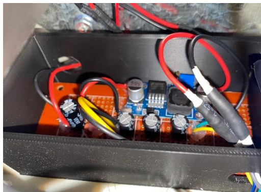
Fig. 13 Instalación de filtro de alimentación.
