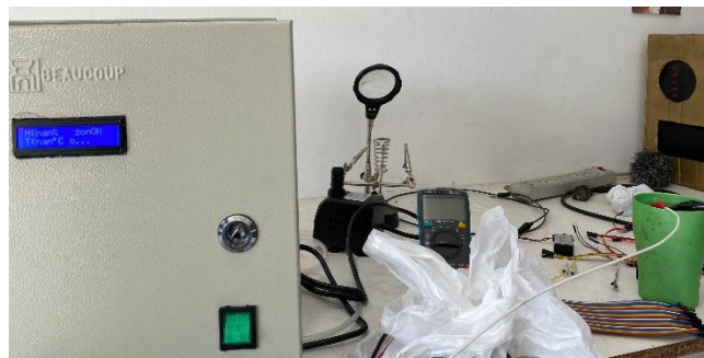
Fig. 18 Prueba de aislamiento y puesta a tierra.
