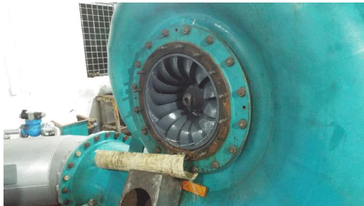
Figura 2 Turbina tipo Francis de HidroImbabura.
