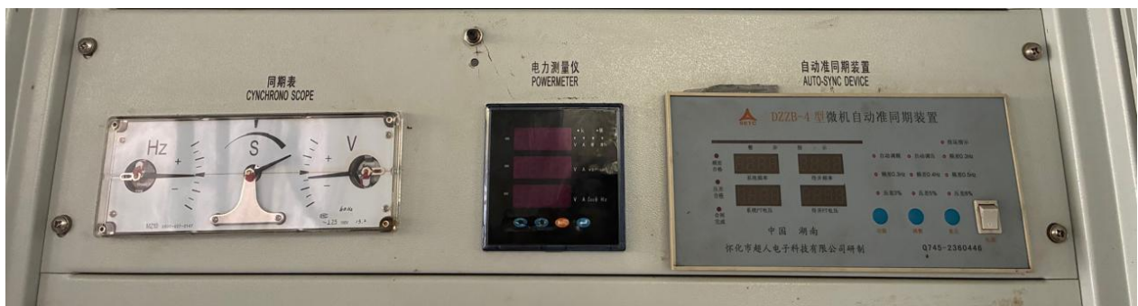
Figura 9 sincronoscopio analógico y el sincronizador automático del grupo generador G3.
