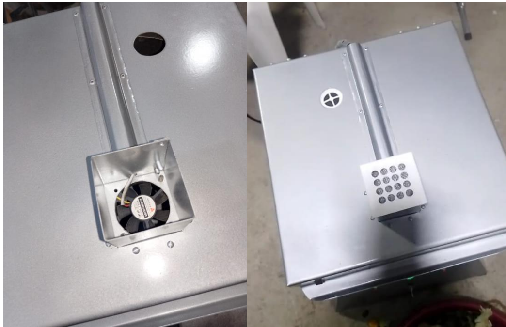
Fig. 4.26 Implementación sistema de aireación
