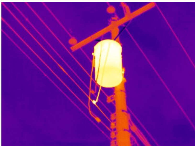
Fig 5: Ejemplo de Termografía previo a análisis.
