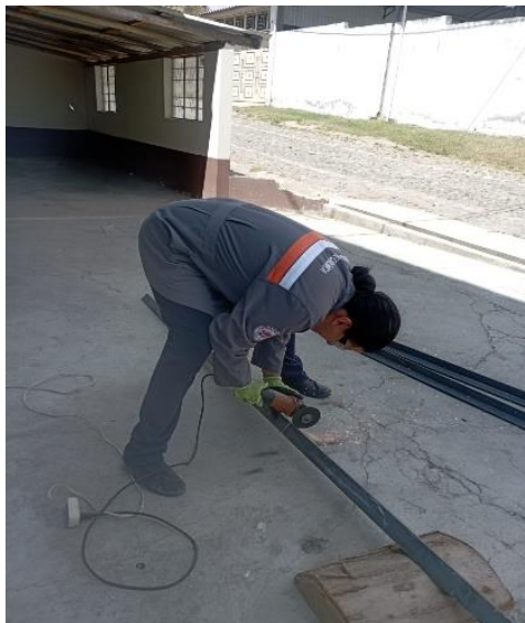
Fig. 4.20 Corte de perfiles.
