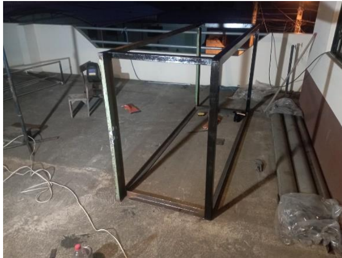
Fig. 4.22 Recubrimiento de pintura.
