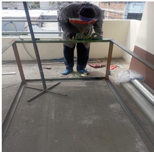
Fig. 4.23 Nivelación de las superficies para las chumaceras.
