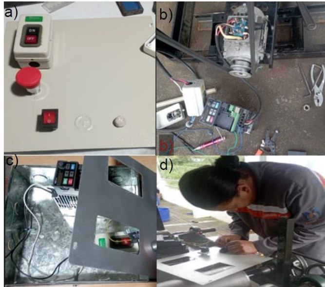
Fig. 4.31 a) Mecanizado del panel de control, b) Cableado de potencia, c) Integración de componentes, d) Interconexión final.
