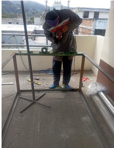
Fig. 4.24 Proceso de perforación en la estructura.
