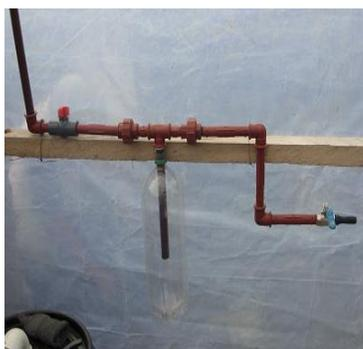
e) Tubería de salida de biogás
