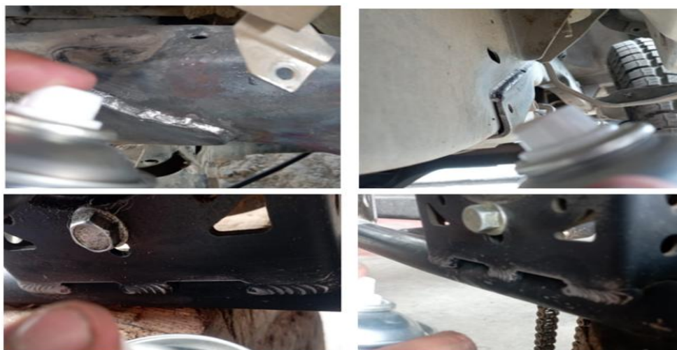
Figura 28. Aplicación del líquido limpiador en las distintas uniones.
