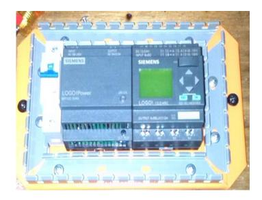
Figura 4. 2 Montaje de dispositivos sobre riel DIN
