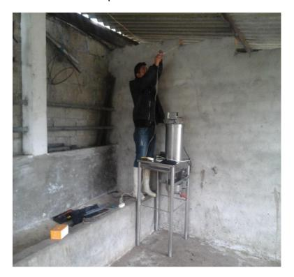
Foto 2 Instalación Máquina dosificadora de leche
