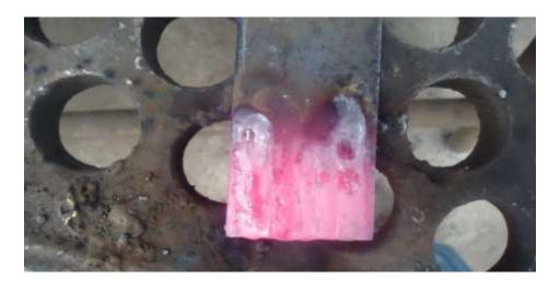
Figura 29 Acabado del relleno con soldadura MIG.
