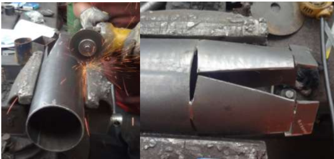
FIGURA 36: Corte pestañas en la camisa de la cámara de combustión.
