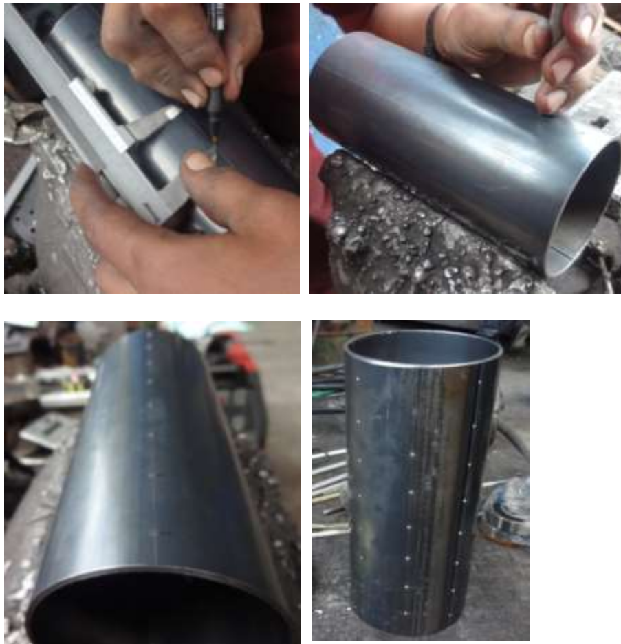
FIGURA 41: Señalización de las perforaciones en el difusor de la cámara de combustión.
