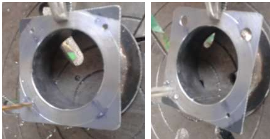
FIGURA 54: Señalización y perforación de la base de la tobera de escape.
