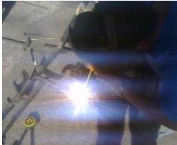
FIGURA 75: Soldadura bases del chasis.
