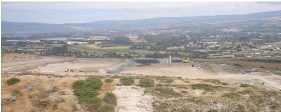
Fotografía 2. Área del relleno en proceso de llenado
