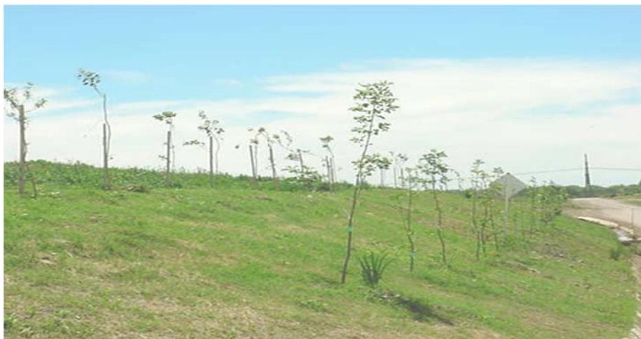
**Fotografía 14. Taludes del relleno cubiertos con quicuyo y arbustos.**
